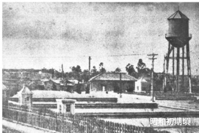
異人館風の八角のとんがり屋根を持つ、6本足の鉄脚に支えられた高さ22.3mの配水塔は、建設当時の大正12（1923）年頃高砂の人々の注目の的であったろう。大正13（1924）年1月1日より配水を初め、昭和41（1966）年7月に現役を引退した。現在、水道敷設のシンボルとして国の「登録有形文化財」に登録され、文化会館の駐車場の一角にそびえている。
